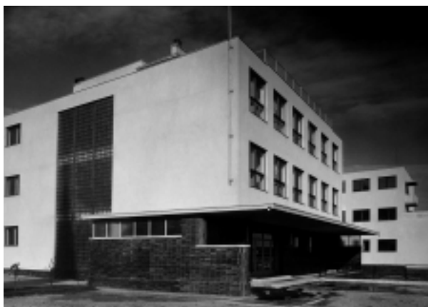
Časť budovy školy s hlavným vstupným priechodom, v období krátko po ukončení výstavby.
